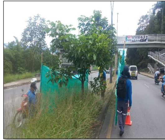
Intervención entrada de la ciudad vía coca cola
